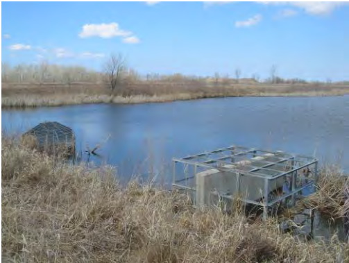
Odney Flaat Dam, Polk County
